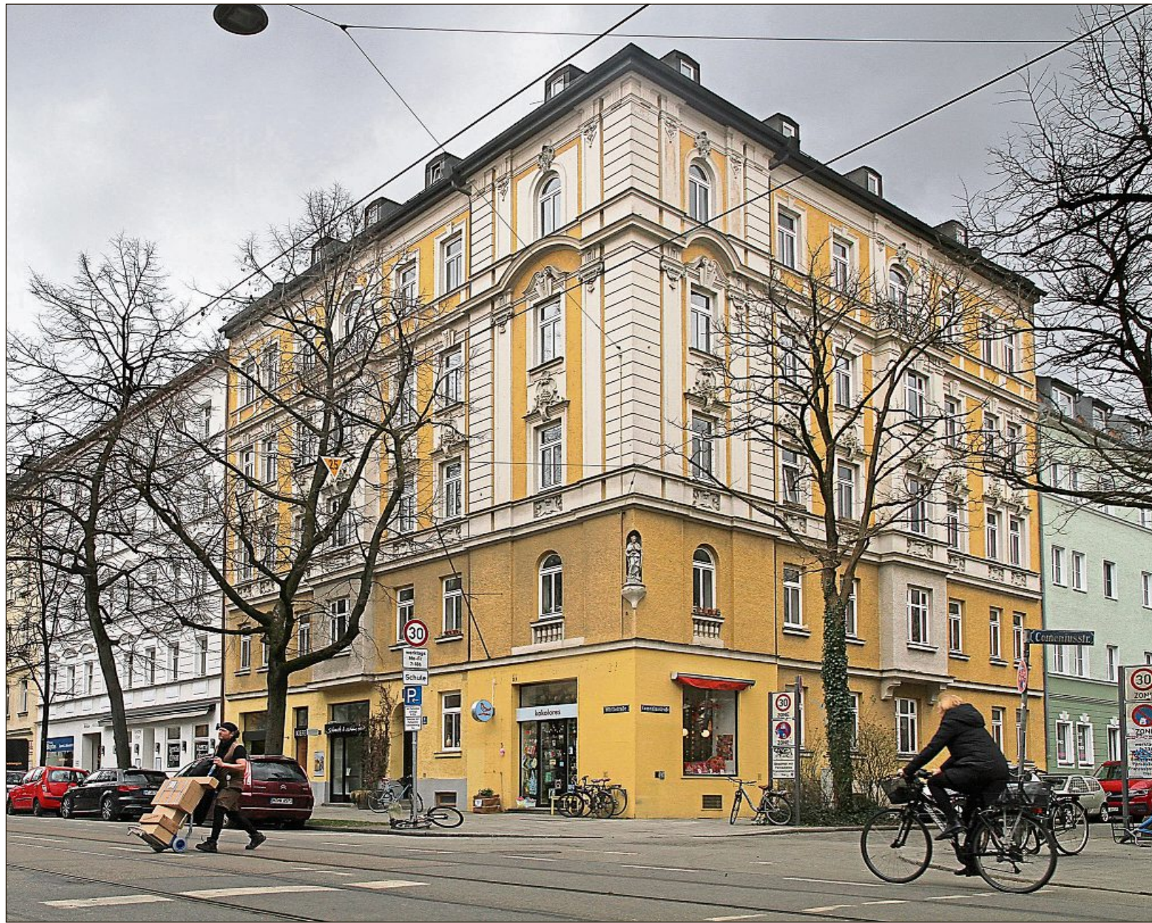
In der Wörthstraße 8 fällt bald die Entscheidung: Kann das Haus dem Spekulationsmarkt entzogen werden?
